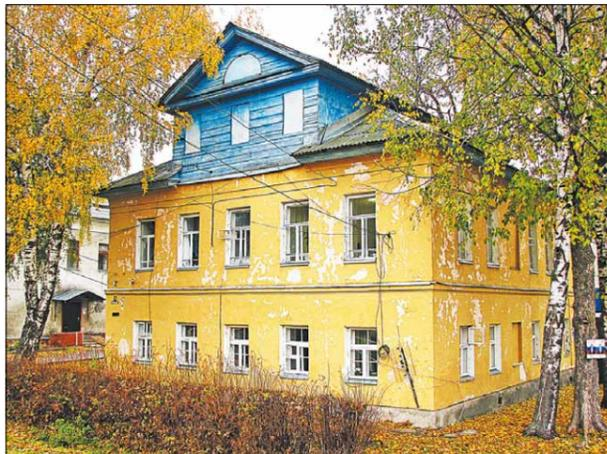
одно здание середины XIX века (ул. Кооперативная, 16). Это двухэтажный каменный дом, нижние окна которого оформлены рамкой с замковым камнем, а верхние – сандриком в виде полки на консолях. Центральная часть фасада не выделена пластически, однако отмечена аттиком с круглым слуховым окном. Дом этот весьма напоминает дом № 6 по Социалистической улице. Как это часто бывало в провинции, строители ориентировались на понравившийся заказчику образец – дом на той же или соседней улице.
