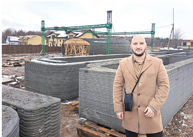
Генеральный директор ООО «Три оси» В.А. Седов на стройплощадке в Черелисино
