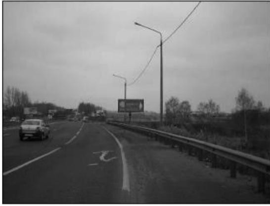
PK 2-21 Сторона А М-8, 256км+170м, справа (ДРИМ №703)
