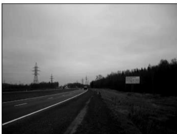
ПК 2-1 Сторона А М-8, 247км+300м, справа.
