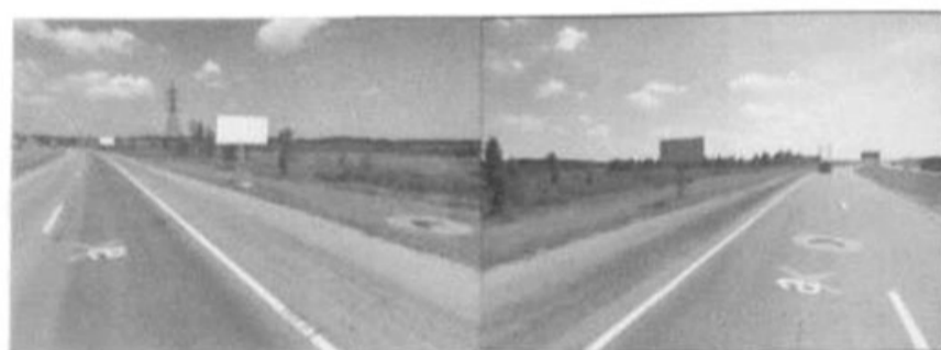
ПК - 12 Сторона А М-8, 250км+110м, справа
