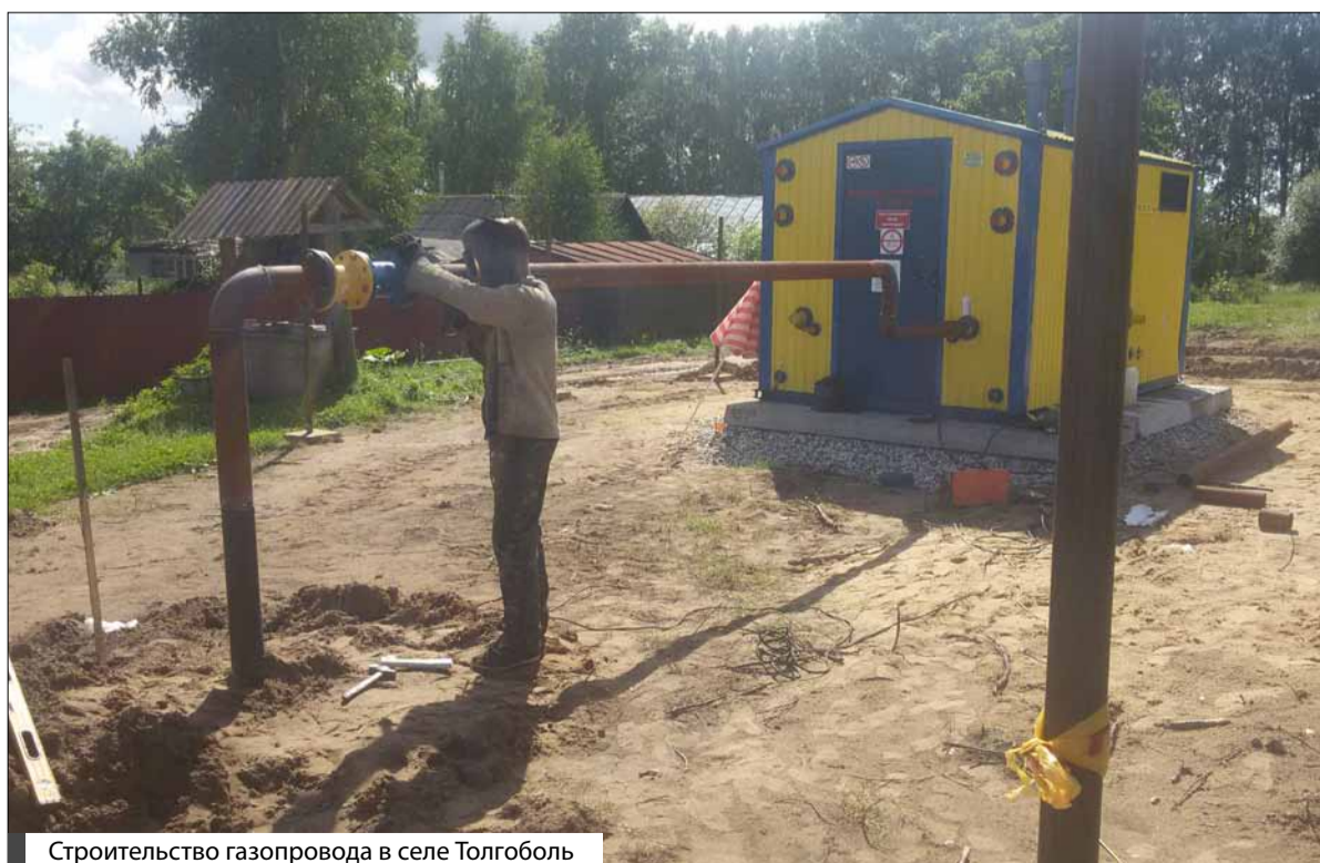
Строительство газопровода в селе Толгоболь
