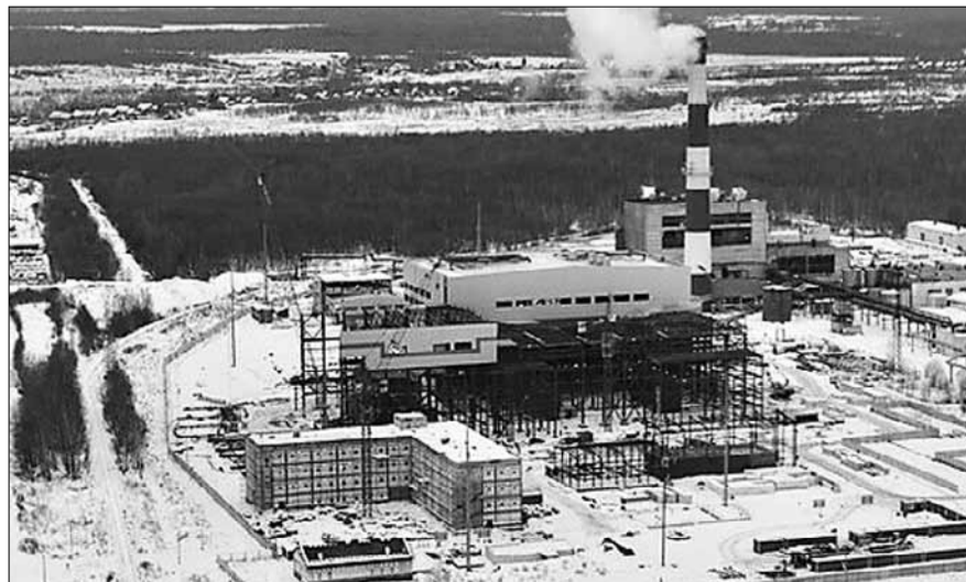
▲ Строительство Хуадянь-Тенинской ТЭЦ. Фото: vk.com/yaraerofoto
