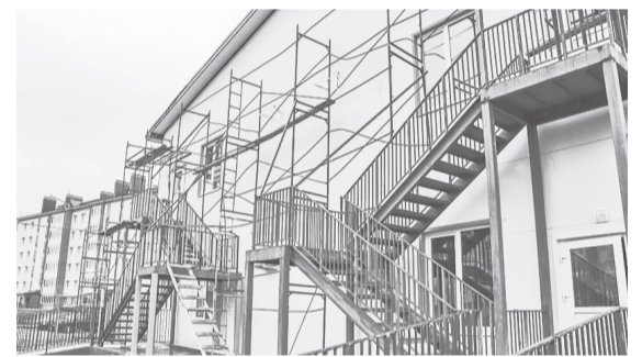
Строительство детсада в Ивняках
