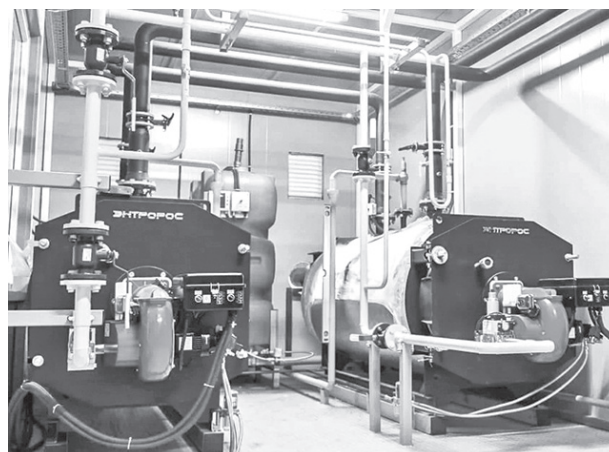
Строится новая блочно-модульная газовая котельная в деревне Иванищево
