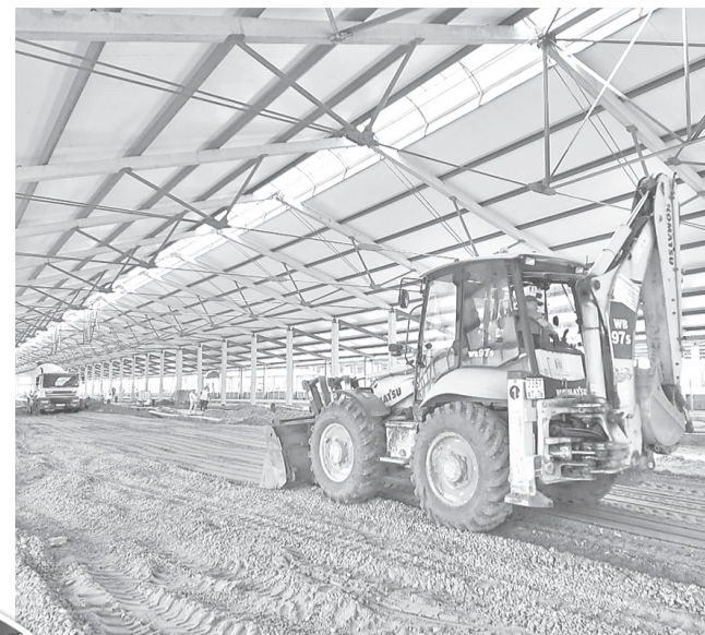
ЗАО «Агрофирма «Пахма». Строительство молочно-товарной фермы
