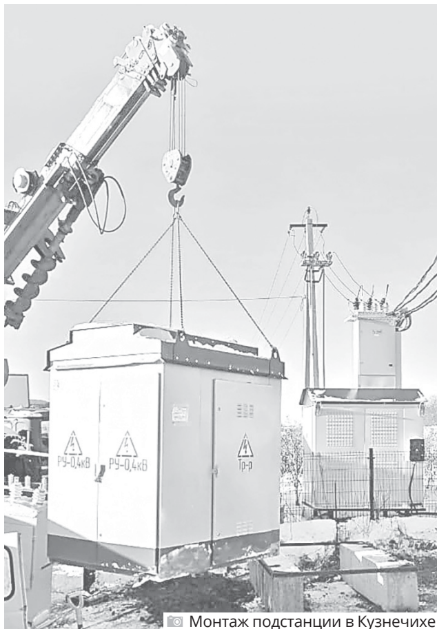
Монтаж подстанции в Кузнечихе
