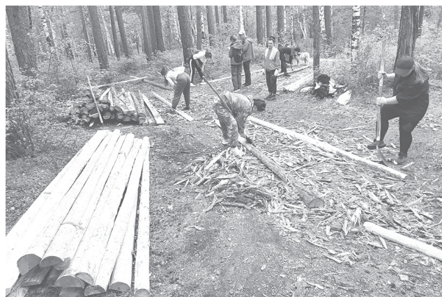
Очистка от коры бревен, подготовленных для устройства ограждения на экотропе
