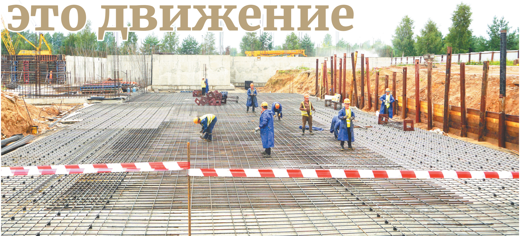
В поселке Заволжье возводят новую школу на 350 мест
