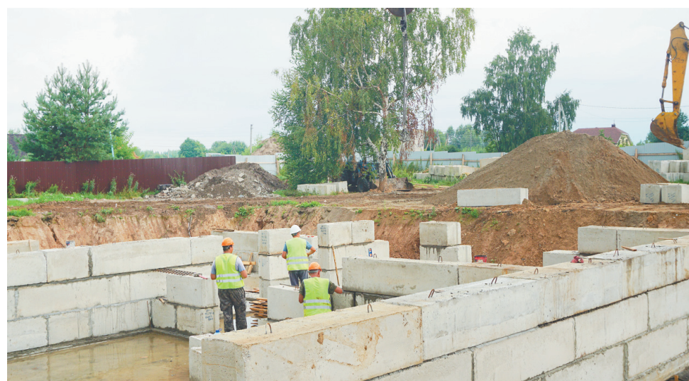
На стройплощадке многофункционального центра в деревне Пестрецово
