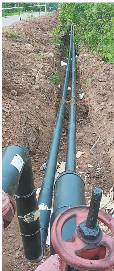
Капремонт участка тепловой сети в с. Курба на ул. Школьной
