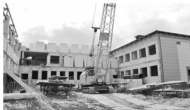
На стройплощадке будущей школы в п. Заволжье
