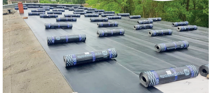
Кровля дома культуры и спорта в с. Сарафанове отремонтирована
