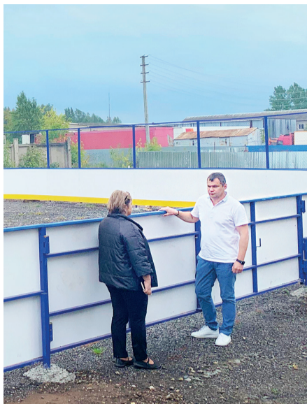
Депутат Ярославской областной думы М.В. Никешин на строительстве хоккейного корта в п. Заволжье
