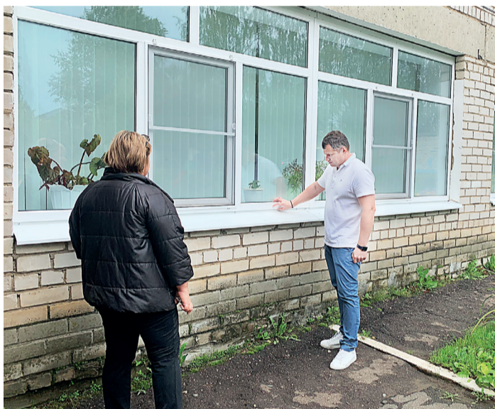
Проверка качества новых окон
