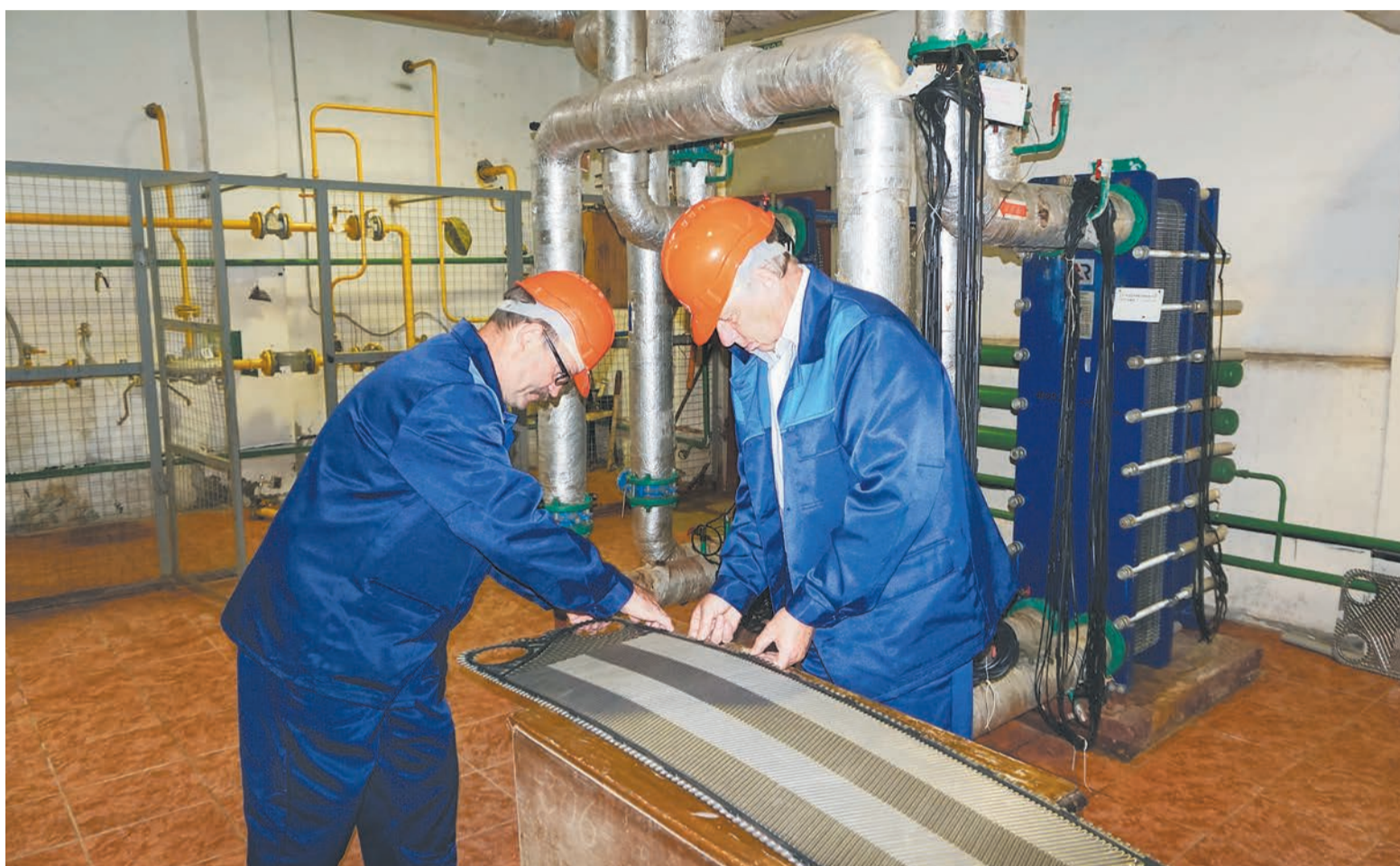
Ремонт в котельной села Толбухино
