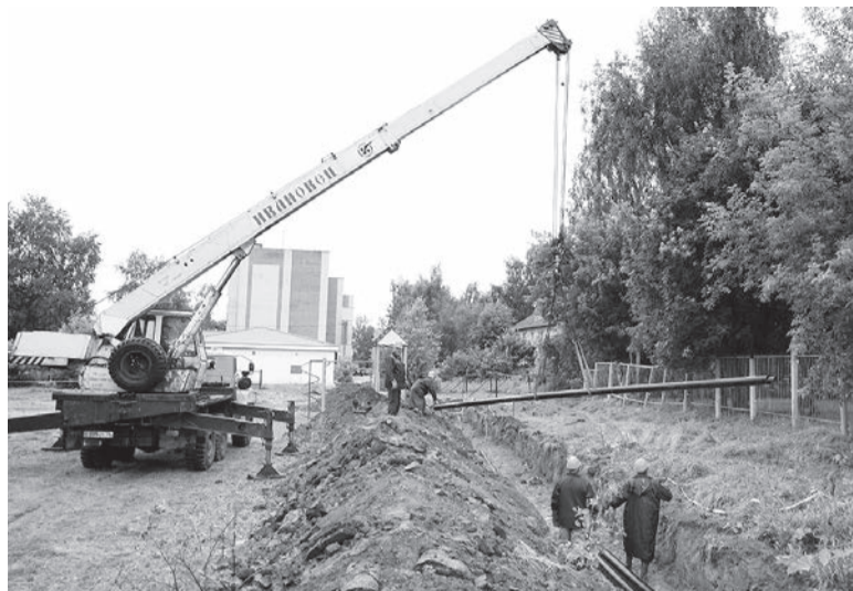
Замена аварийного участка теплотрассы
