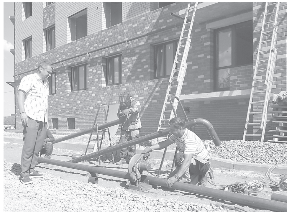
Руководитель строительной компании «Берега», депутат Ярославской областной думы М.В. Никешин на объекте
