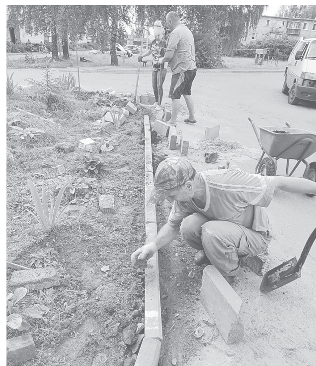
Работы по благоустройству «Зеленого островка»
