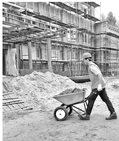
В Михайловской школе идет ремонт
